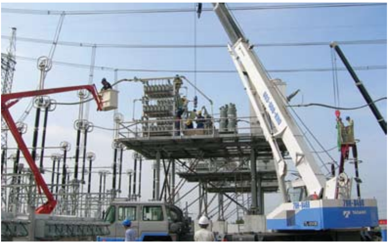
Thi công lắp đặt tụ bù dọc tại Trạm biến áp 500kV Plei Ku năm 2004 Ảnh: Minh Trí
