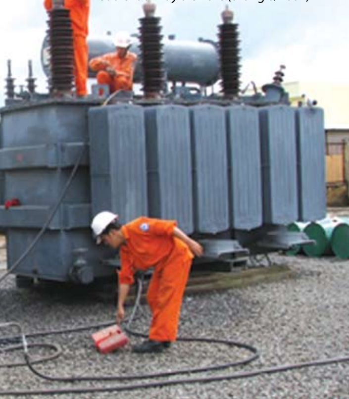
Sửa chữa máy biến thế (tháng 8/2007)
