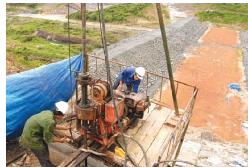
Khoan phụt màng chống thấm nền đập (tháng 9/2008). Ảnh: Ngọc Hà
