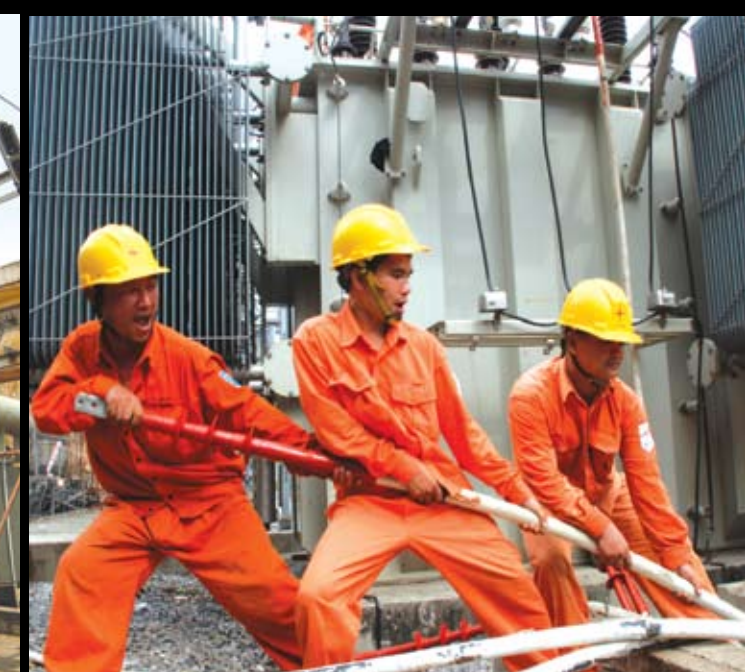
Công nhân Xí nghiệp Quản lý lưới điện 110 kV (thuộc HNPC) nâng cáp TBA 110 kV E8 - Yên Phụ (tháng 7/2009) Ảnh: Hoa Việt Cường
