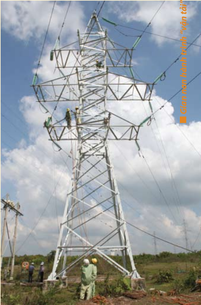
Truyền Tải Điện Miền Đông 1 (thuộc PTC 4) thi công công trình căng dây đường dây 220kv Phú Mỹ - Long Thành thực hiện vào tháng 09 năm 2009
