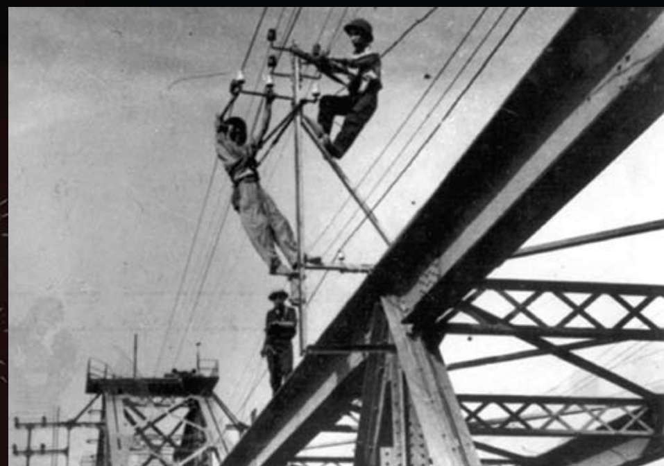
Chữa điện cầu Long Biên trong chiến dịch "Điện Biên Phủ trên không" cuối tháng 12/1972 Ảnh: Trần Nguyên Hơi
